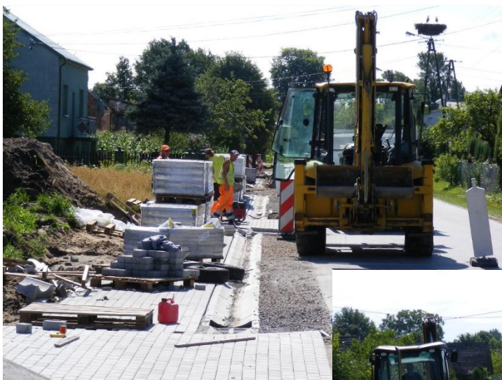
Fot. Budowa chodnika w Mechowcu.
